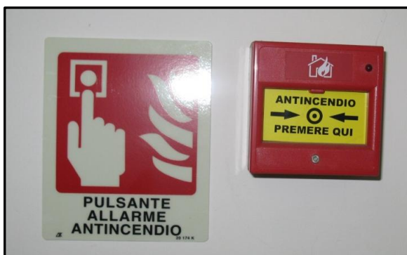
Figura 5 - Pulsanti allarme antincendio.
