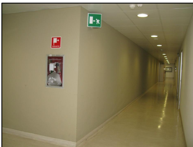
Figura 13 - Cassetta idrante UNI 45 con lancia e manichetta e segnaletica antincendio
