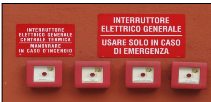
Figura 11 - Pulsanti sgancio energia elettrica generale (Nei pressi del passo carraio)
