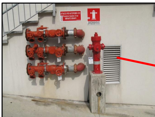
Figura 7 - Attacchi motopompa VVF e Idrante UNI 70 (Nei pressi del passo carraio)
