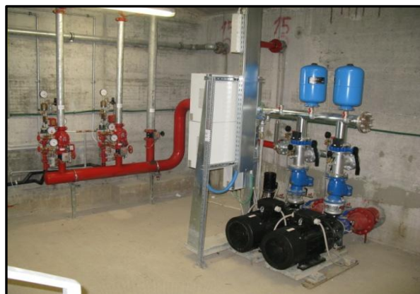
Figura 6 - Centrale idrica antincendio Piano -2
