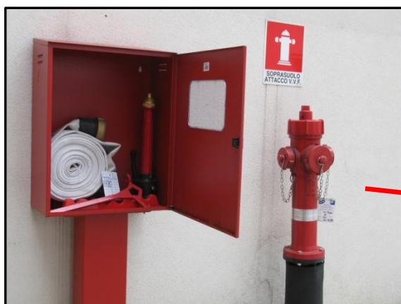
Figura 9 - Idrante sopraelevato UNI 70. (Cortile, nei pressi del locale congelatori -80°C)
