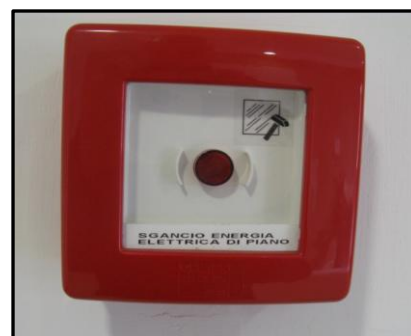
Figura 12 - Pulsante sgancio energia elettrica di piano
